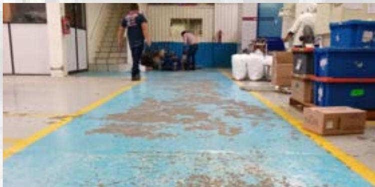
Por medio de máquinas desbastadoras se removerán todos los contaminantes, así como los recubrimientos anteriores, con el fin de asegurar la perfecta adherencia de nuestro recubrimiento Nu Floor Oil Stop
